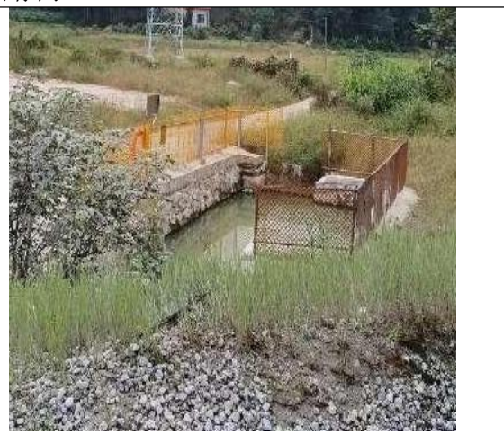
洗车平台沉淀池
