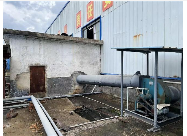
中频炉废气处理设施
